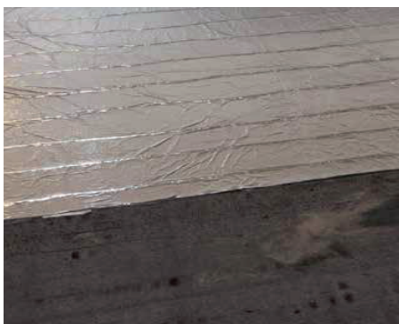
POSA DELLA PELLICOLA SCIUGLINEVE
