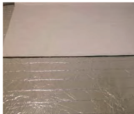
COPERTURA DELLA PELLICOLA CON MANTO IN PVC
