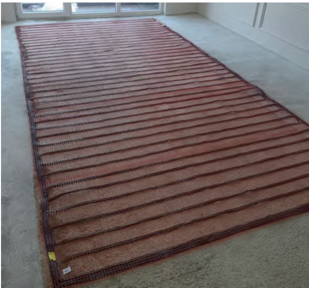
RETE APOGGIATA SUL PAVIMENTO
