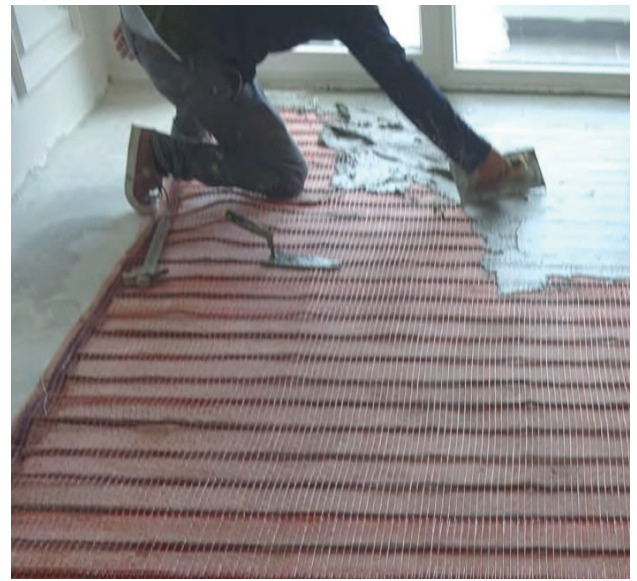
RASATURA LEGGERA PER IL FISSAGGIO DELLA RETE
