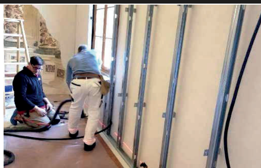
INSTALLAZIONE TELAI METALLICI
