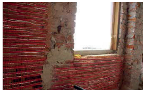
POSA DEI RISCALDATORI SU UN MURO IN MATTONI
