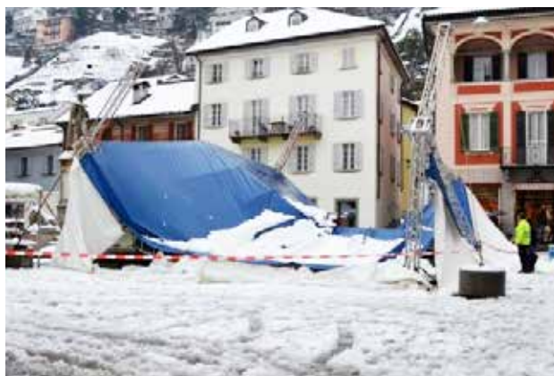
COPERTURA IN PVC CROLLATA SOTTO IL PESO DELLA NEVE
