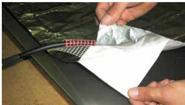
DISTACCO DELLA CARTA DI PROTEZIONE DALL'ALLUMINIO ADESIVO
