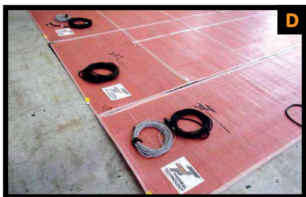
D. Predisporre le prolunghe di alimentazione come previsto da disegno esecutivo.
