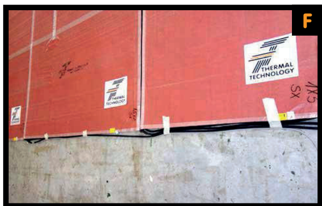
F. Far passare le prolunghe sul bordo dell'elemento scaldante, o tra elemento e elemento quando possibile.
