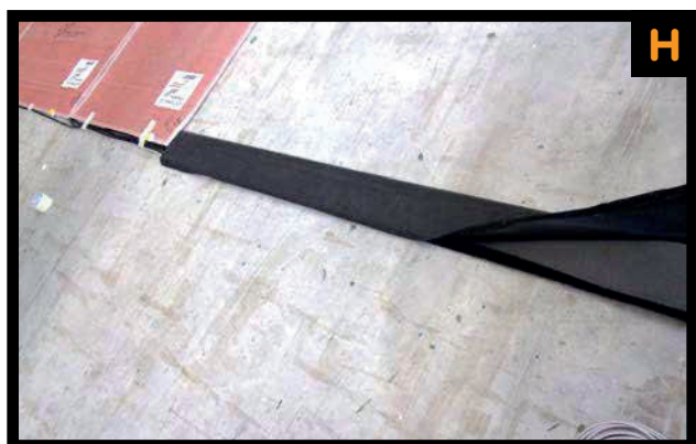
H. Chiudere la canalina con il coperchio e avvolgerla nel materiale elastico e antiscivolo fornito.
