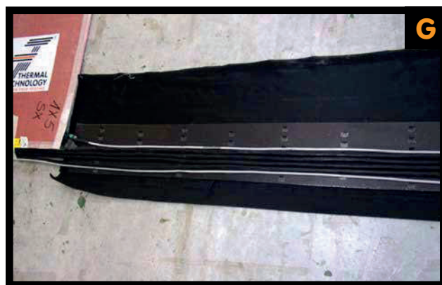
G. I cavi vengono raggruppati nel punto indicato da progetto dove un'apposita canalina li convoglierà sino al quadro elettrico.
