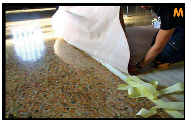
M. Una volta effettuata la verifica del funzionamento di tutti gli elementi, posare la moquette tramite normale nastro biadesivo.
