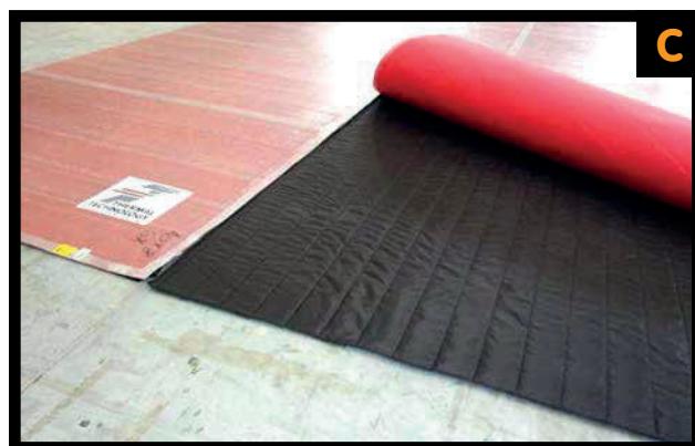
C. Posare sopra l'isolamento termico gli elementi scaldanti.
